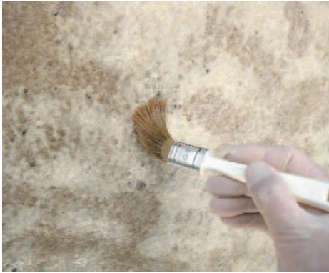
Intervento con la resina epossidica 10 10 CFS: con il pennello si bagna il punto da riparare, poi si prepara della resina con Microfibre Minerali e applicazione con spatola liscia
