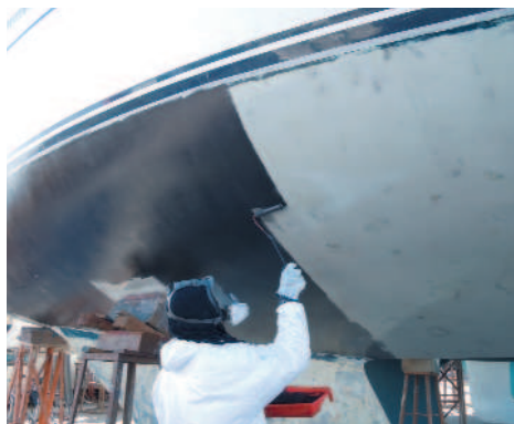
Applicazione mano di 10 10 CFS, altre mani con additivo A20 di colore nero (grafite) e mano di Epoxy Primer
