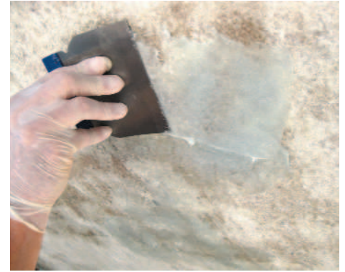
Intervento con la resina epossidica 10 10 CFS: con il pennello si bagna il punto da riparare, poi si prepara della resina con Microfibre Minerali e applicazione con spatola liscia
