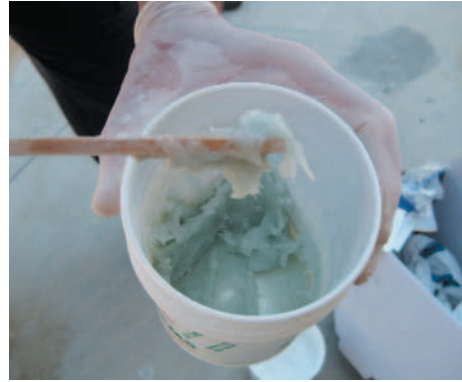
Intervento con la resina epossidica 10 10 CFS: con il pennello si bagna il punto da riparare, poi si prepara della resina con Microfibre Minerali e applicazione con spatola liscia
